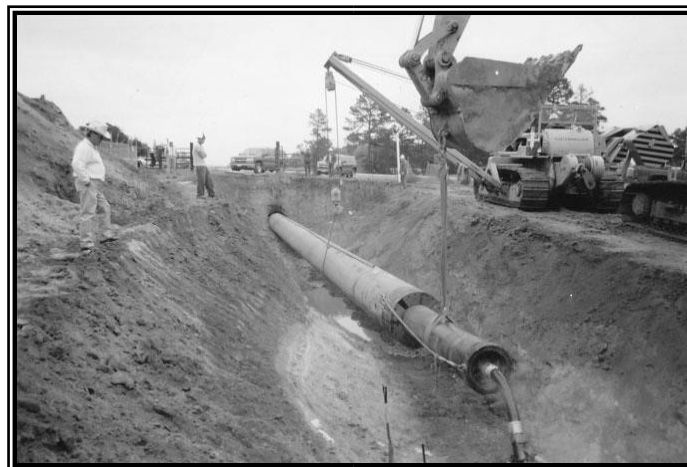
Gráfico 20: Hincado de Tuberías
